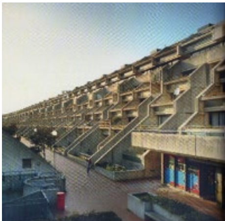
FIGURA 4 (esq.) – Vista interna da edificação principal.
