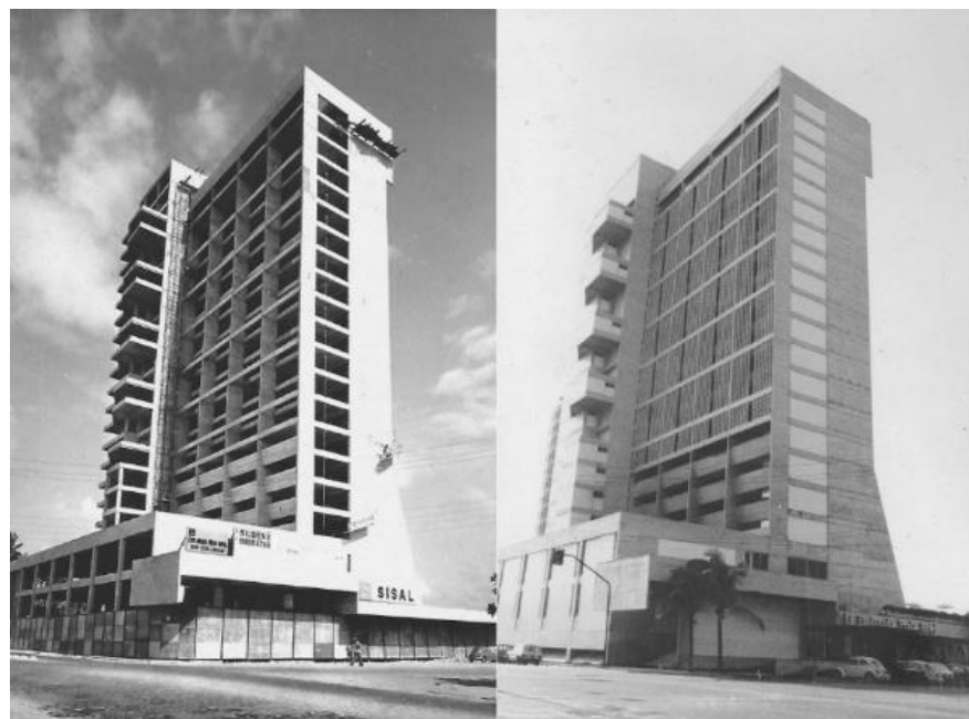
FIGURA 4 – Fotos do Hotel Esplanada (1973-1978), Fortaleza, Ceará – Destaque para a primeira foto do edifício em construção, com placas indicando o financiamento da Sudene e Embratur, além da construção pela Sisal.
