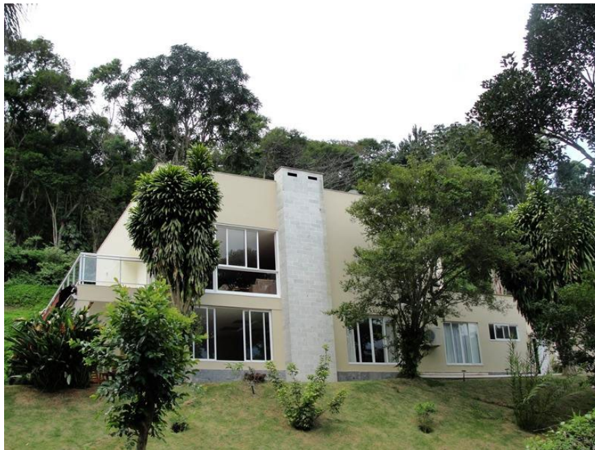
FIGURA 7 – Fachada Sul em 2015.
