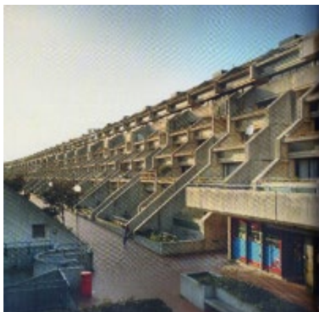
FIGURA 4 (esq.) – Vista interna da edificação principal.
