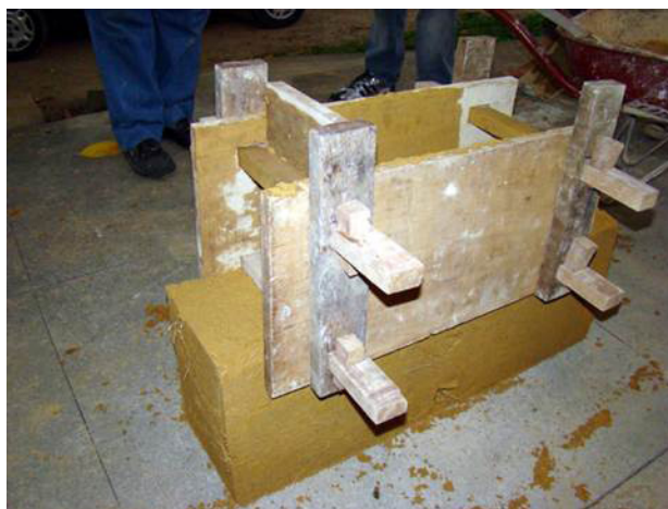
FIGURA 2 – Demonstrativo da fôrma de madeira retangular da taipa de pilão.
