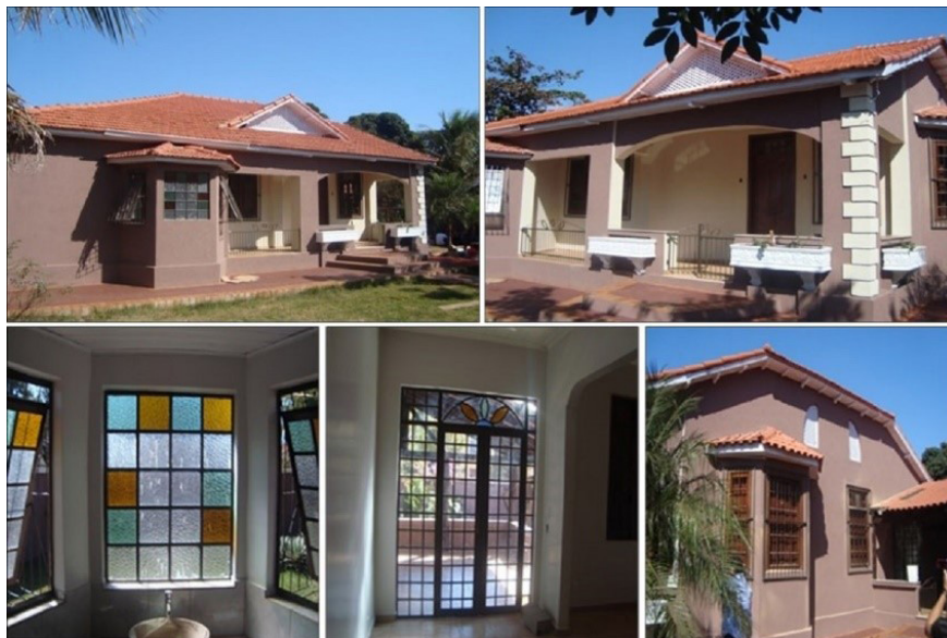
FIGURA 2 –Fachada frontal, portas e janelas da residência do Dr. Boaventura, Rio Brilhante, Mato Grosso do Sul.
