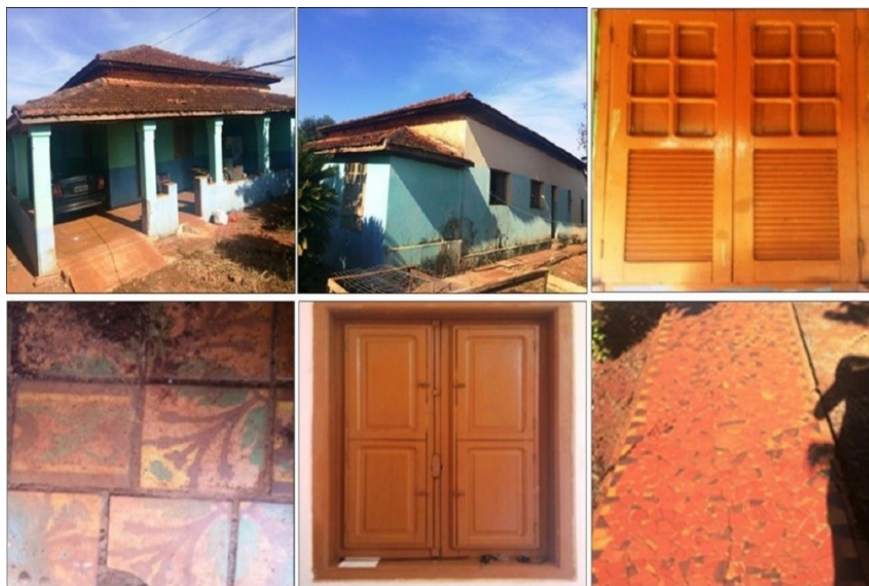
FIGURA 8 –Fachada frontal, lateral, janelas e paginação de piso da residência do Sr. Jair Barbosa, Rio Brilhante, Mato Grosso do Sul.
