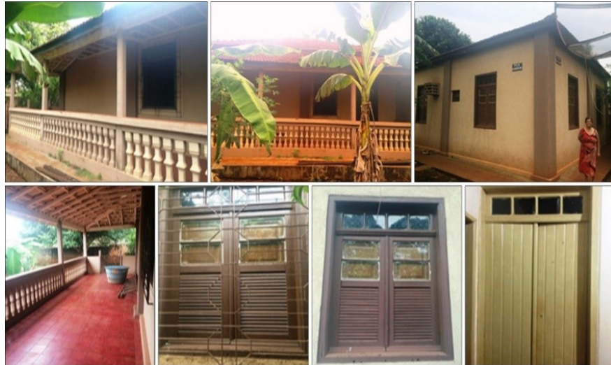
FIGURA 3 –Varanda, janelas e portas da residência do Sr. Martin Campeiro, Rio Brilhante, Mato Grosso do Sul.
