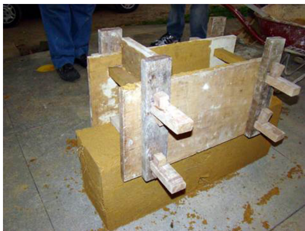
FIGURA 2 – Demonstrativo da fôrma de madeira retangular da taipa de pilão.
