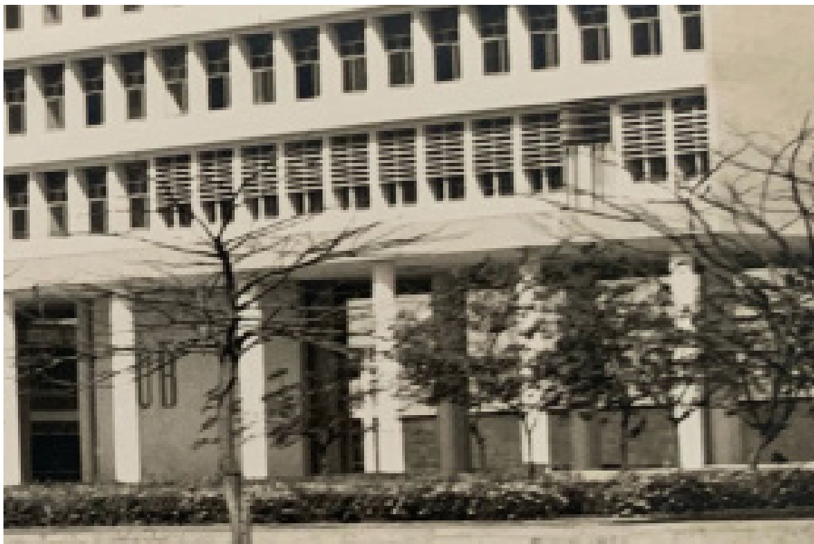
FIGURA 7 – Fachada do edifício JMM com a instalação dos protótipos dos brises, década de 1960
