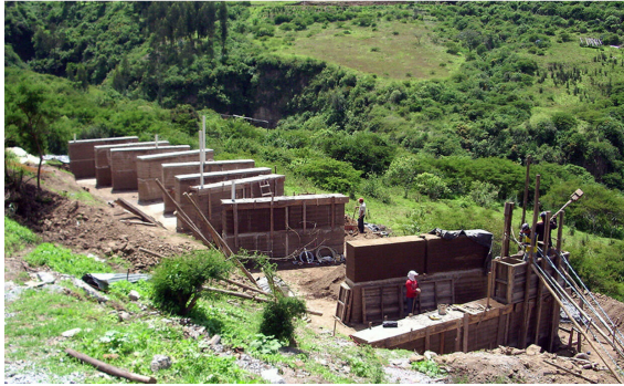
FIGURA 6 – Casa entre Muros: construção de paredes em taipa de pilão (6a) e circulação integrada ao entorno (6b).
