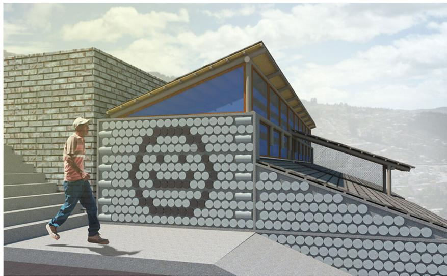
FIGURA 3 – Materialidade composta com corpos de prova de concreto no projeto Fábrica Cultural Atacucho.
