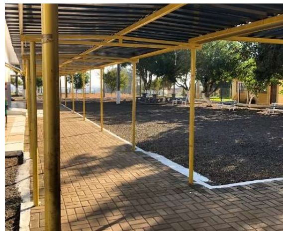
FIGURA 8 - Caminhos da Escola Oficina
