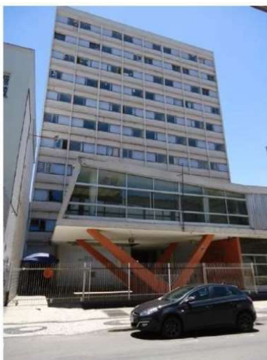
4 EDIFÍCIO PAM MARECHAL
