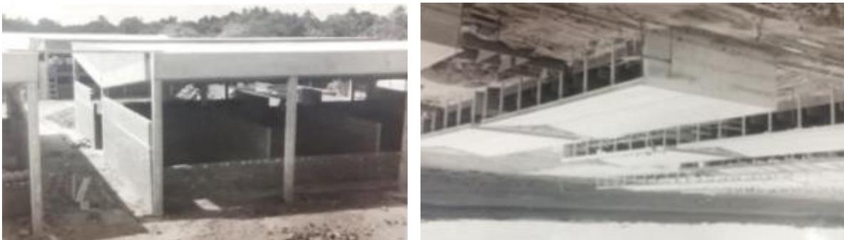
FIGURA 13 e 14 - Colocação das alvenarias e pavilhões em diferentes fases de montagem (Sancho)
