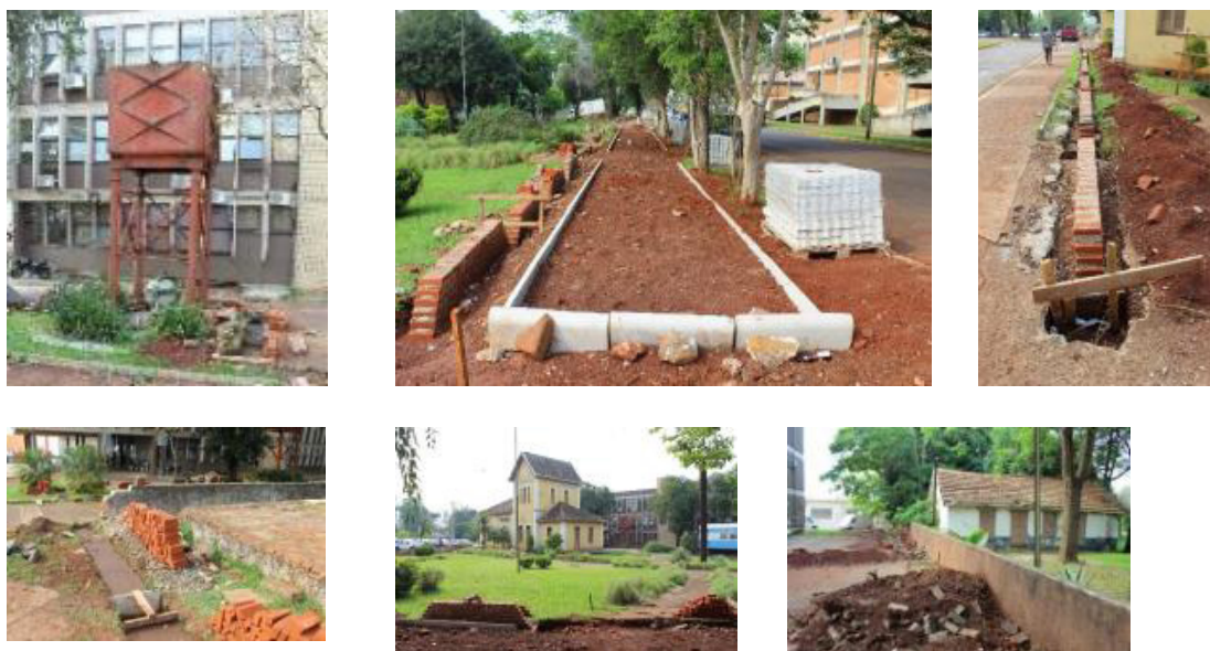
FIGURA 10 – Processo de cercamento da gare.
