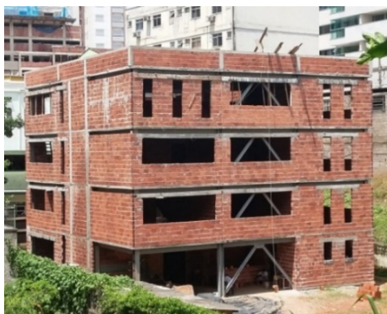
FIGURA 2 – Edifício de ensino da IPV em fase inicial de construção.
