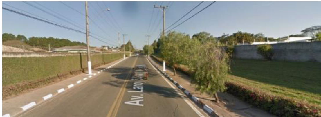
Figura 7: Rua de acesso a condomínios fechados entre os muros dos mesmos. FONTE: Google Street View, 2019.
