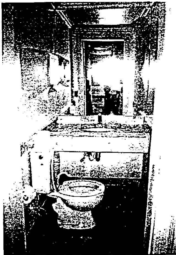
Vista geral do sanitário masculino de uso público no primeiro pavimento, com dimensões e posicionamento das peças sanitárias e componentes (papeleira, toalheiro, espelho), comprometendo a sua utilização por usuários de cadeiras de rodas e outros com mobilidade reduzida.
