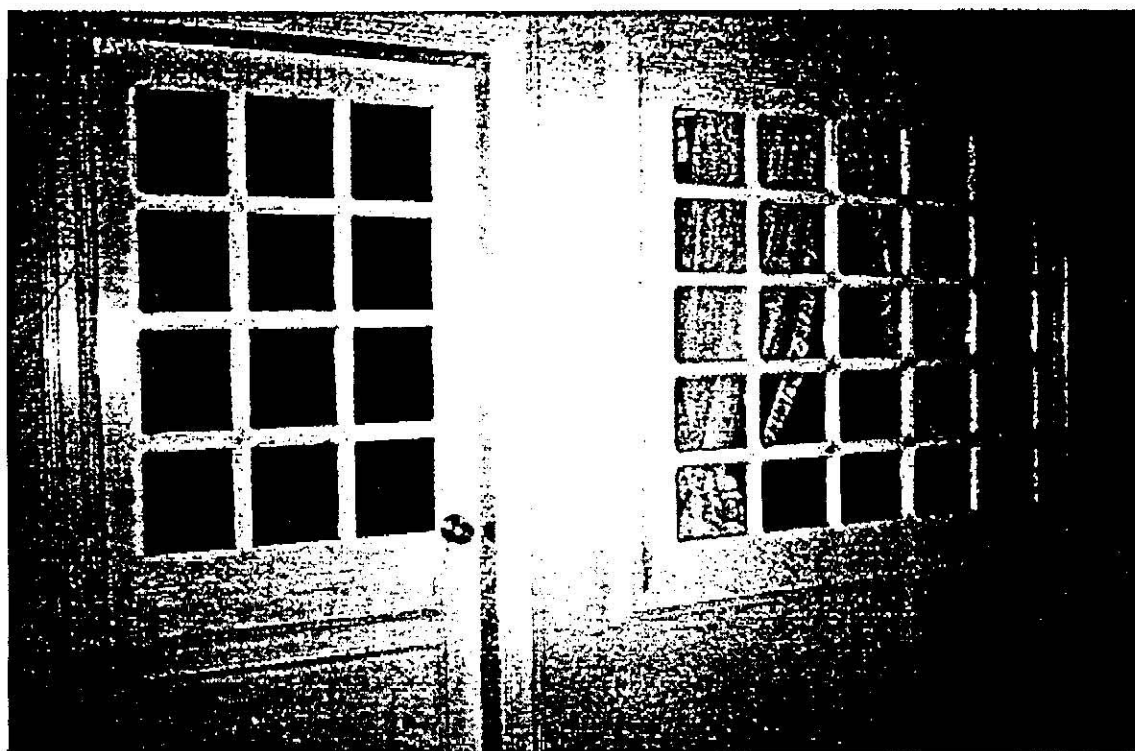
Vista das esquadrias (porta de acesso e janela) da sala de Controle de internação voltadas para o corredor, o que torna devassado o seu interior.
