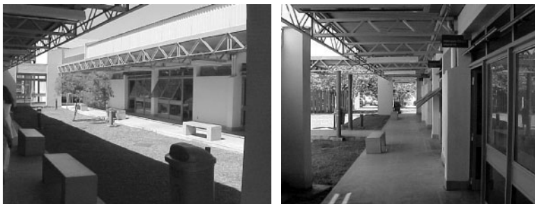
Figs. 01 e 02: Vistas dos pátios do Hospital Lourenço Jorge
