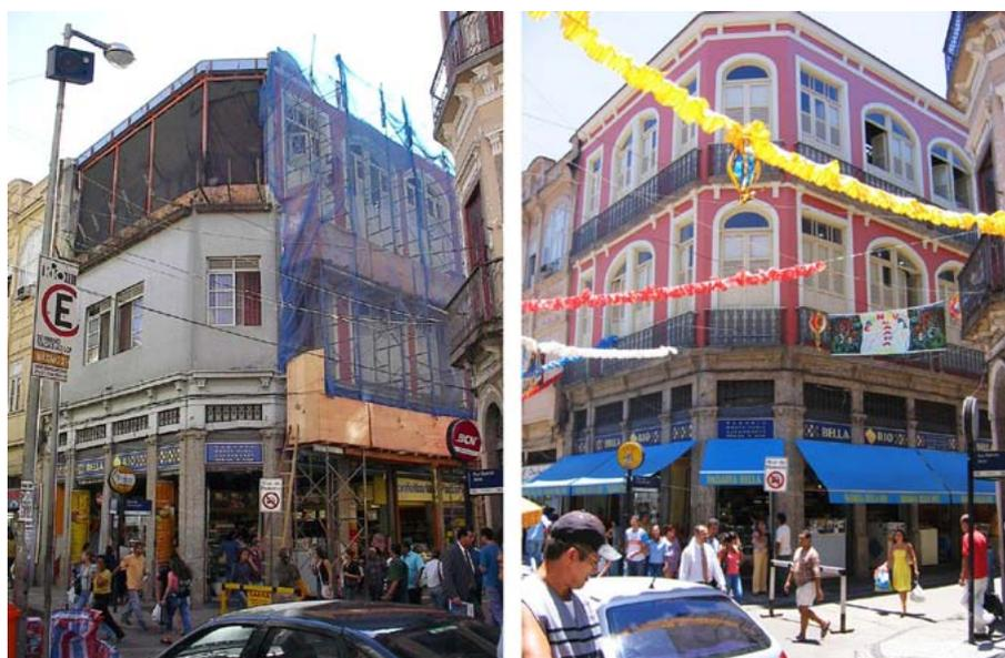
Fig. 2 Edifício situado na esquina da Rua Buenos Aires com Rua da Conceição, após sinistro. A foto à esquerda mostra o edifício em reconstrução; notem-se os vãos alterados e em desacordo com a linguagem original. A foto à direita mostra o edifício reconstruído e a reforma, quando foram descobertas estrutura, cantarias e argamassa originais
