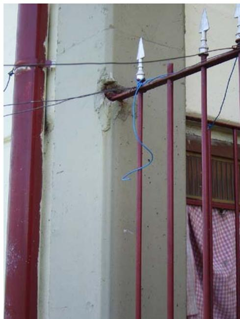
Figura 2: Fixação inadequada da grade de proteção na armadura do pilar, motivada pela falta de elementos de fechamento e controle de acesso aos ambientes internos do condomínio.
