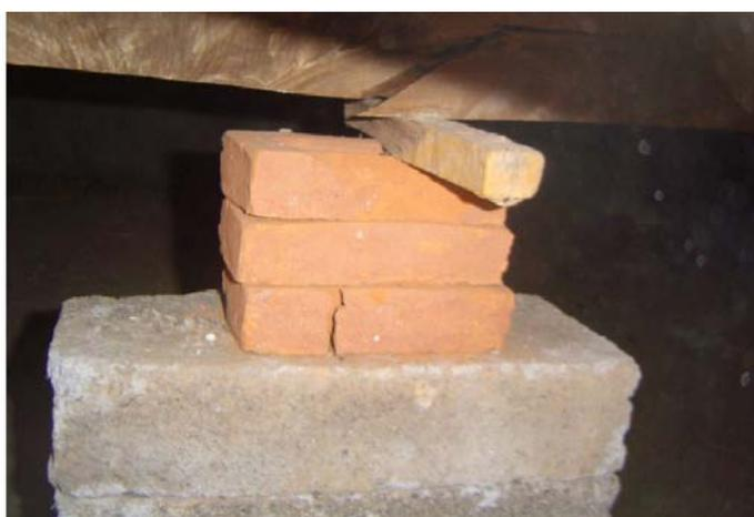
Figura 3: Falha de supervisão e teste na etapa construtiva de Cobertura. Materiais de baixa durabilidade; improvisações como a base de apoio das estruturas do telhado.
