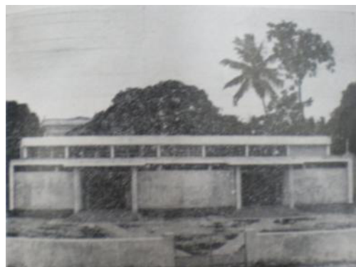
FIGURA 4 - Dispensário de Tuberculose, no Bairro de Afogados, Recife. Fonte: Pernambuco, 1950.
