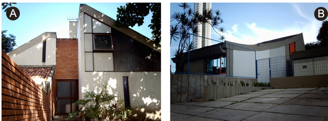
FIGURA 2: A- Residência Alfredo P. Corrêa, Delfim Amorim e Heitor Maia Neto, 1969; B- Residência Paulo Meirelles, Frank Svensson & Marcos Domingues, 1968. Fotos dos autores.
