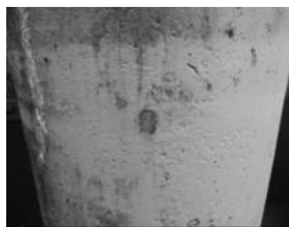
FIGURA 19 - Coluna do claustro após reforço estrutural
