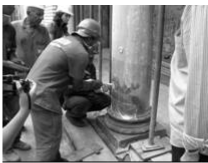
FIGURA 18 - Injeção de resina
