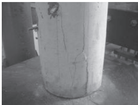
FIGURA 16 - Fissuras apresentadas pelo corpo de prova com passo de 45 cm no ensaio à compressão axial
