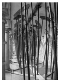
FIGURA 17 - Escoramento das arcadas e abóbadas de aresta do claustro
