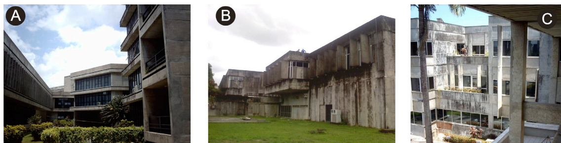
FIGURA 1: A- Sede da Rede Ferroviária, Frank Svensson & Marcos Domingues, 1970; B- CAC-Centro de Artes e Comunicação, Reginaldo Esteves, 1973; C- CHESF, Dinauro Esteves & Maurício Castro, 1975. Fotos dos autores
