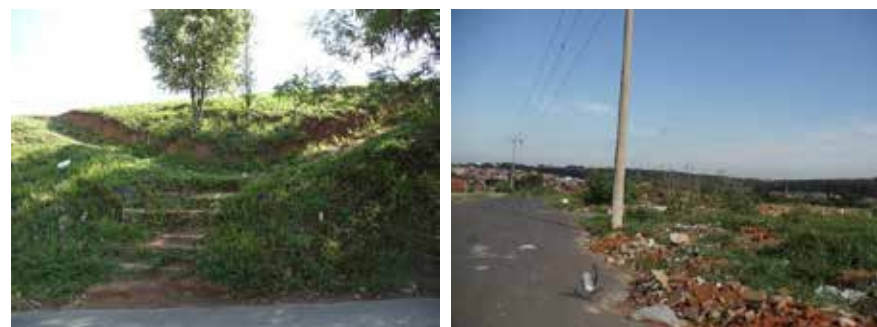
FIGURA 24 Estado de conservação dos espaços livres Fonte: acervo da autora, 2013.
