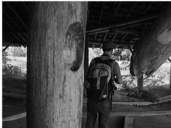
FIGURA 5 - Detalhe de mão-francesa desencaixada
