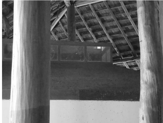
FIGURA 10 – Detalhe da ventilação zenital protegida pela grande cobertura
