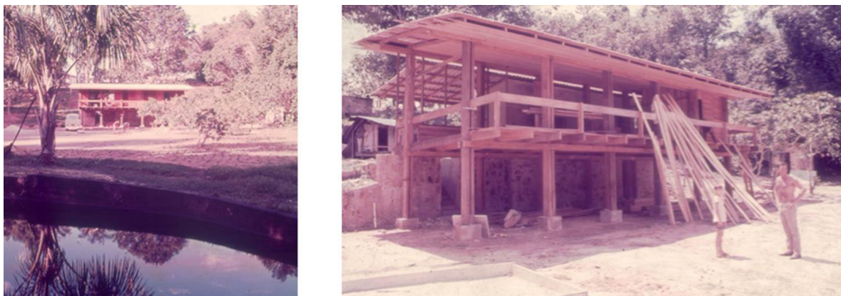
FIGURA 7 – Residência da Rua Recife, 1962. Primeira residência do arquiteto em Manaus. À esquerda notar o igarapé em primeiro plano. À direita, a casa em construção c. 1966.
