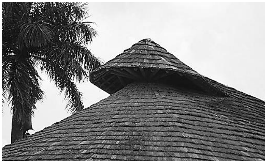
FIGURA 16 - Detalhe de uma das aberturas zenitais na cobertura principal
