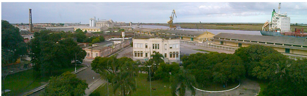
FIGURA 5- Prédio do curso de Engenharia de Petróleo – UFPEL
