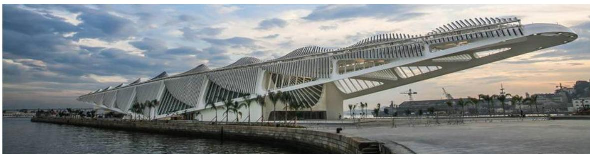
FIGURA 6 - A linearidade do edifício pousado no píer e os dois grandes balanços nas extremidades.
