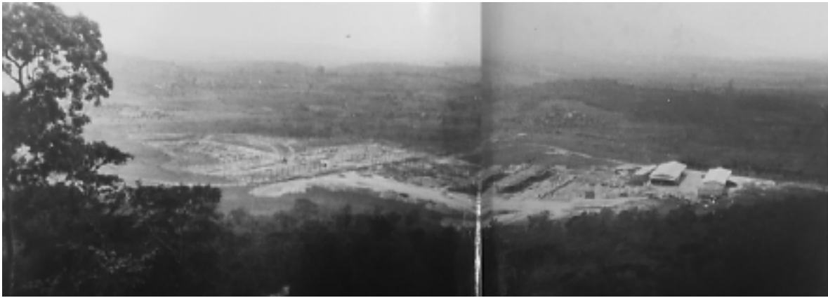
FIGURA 8 - Panorâmica da obra do Sanatório de Curicica em seu início (colocação de pilares)
