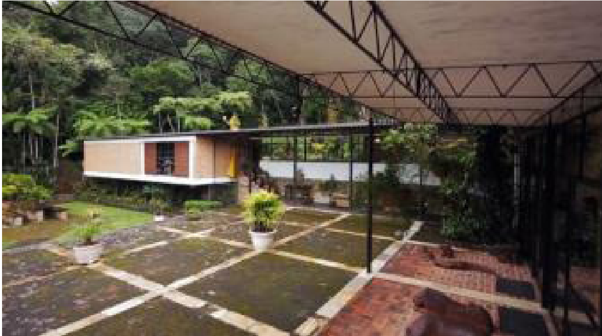
FIGURA 25 - Residência Lota Macedo Soares (1951-1953). Treliças de vergalhões em formato V sustentando a telha de alumínio, fazendo com que essa cobertura aparente maior leveza.
