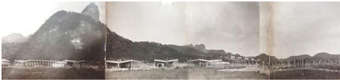
FIGURA 9 - Panorâmica da obra do Sanatório de Curicica
