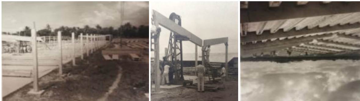
FIGURA 10, 11 e 12 - Fotografias da obra do Sanatório de Sancho – Colocação dos pilares, vigas e cobertura
